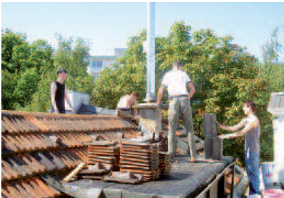
Dachreparatur in Eigenarbeit mit gebrauchten Dachziegeln.
